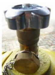
Foto 1 Ventil mit Verschlussmutter
